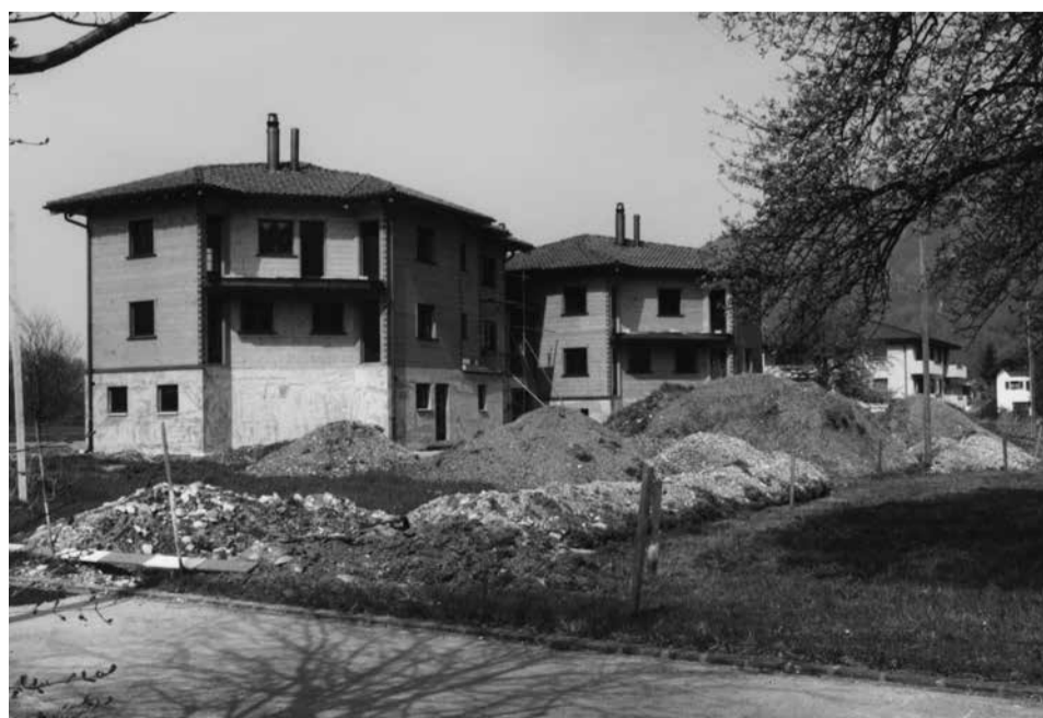
Neue Wohnhausanlage in Holzbauweise in Balzers
