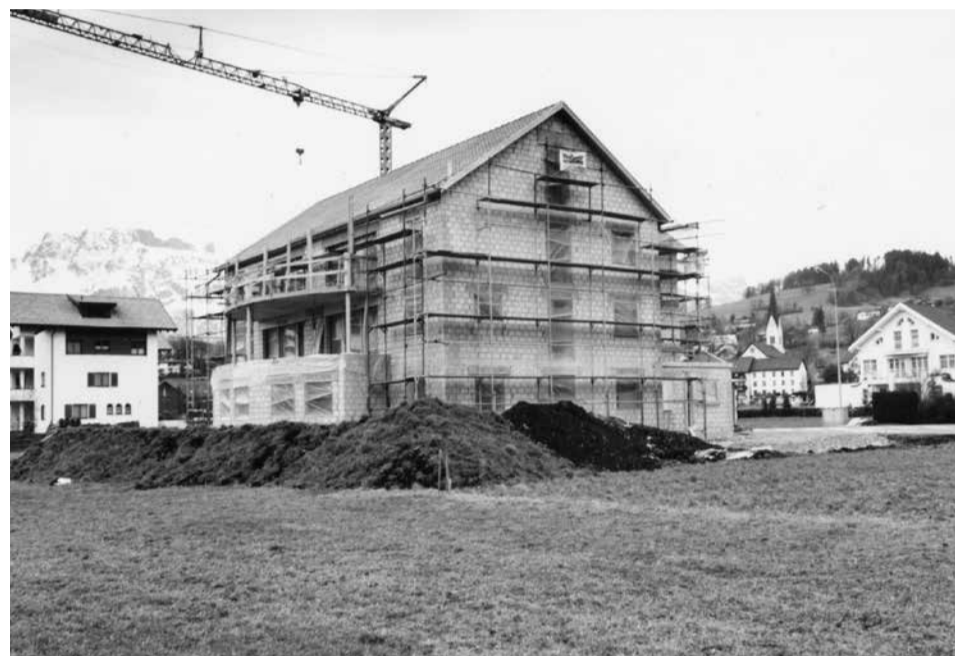
Mehrfamilienhaus-Rohbau in Eschen
