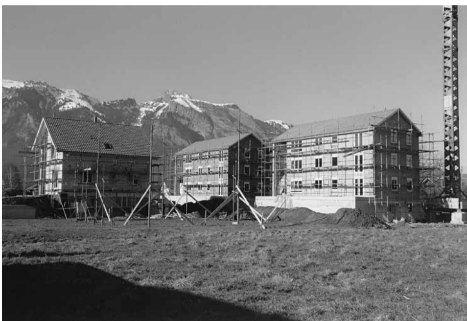
Einfamilien- und Mehrfamilien-Wohnungsbau in Ruggell
