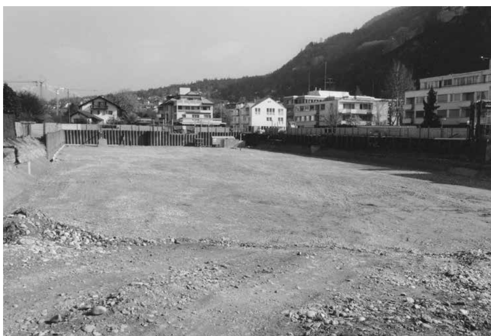
Baugrube für die in Angriff genommene Grossüberbauung auf dem Areal des ehemaligen Real-Gartencenters in Vaduz
