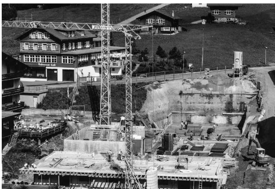
Für Malbuner-Verhältnisse entsteht hier eine Grossbaustelle
