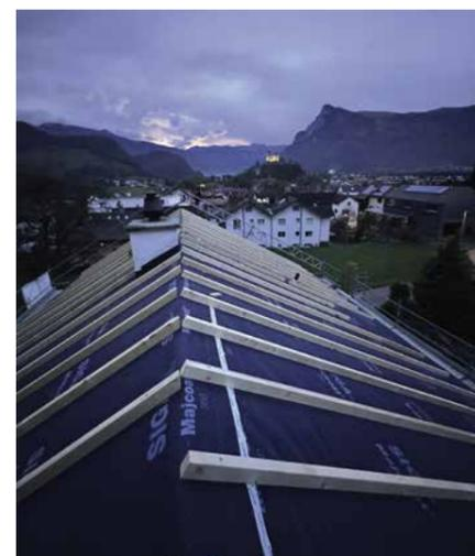
Unterdach und Hinterlüftungslattung
